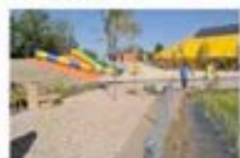
Canal de grava / Almacenamiento de agua tratada para riego. Gravel bed / Purified water storage for irrigation needs.
