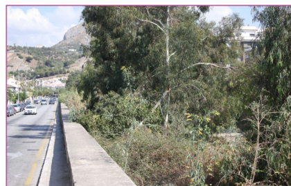
Imagen del muro de contención del arroyo. José Sánchez-Laulhé, 2009
